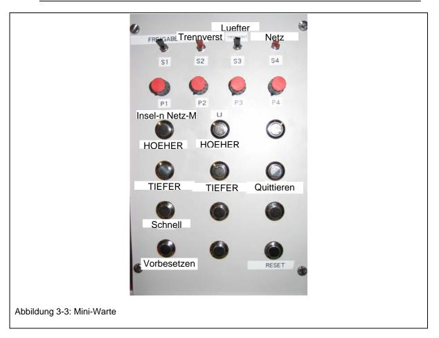
Die Mini-Warte (Abbildung 3-3) verfügt über Taster und Schalter. Die erste Spalte "Insel-n" bzw. Netz-M" ändert den Ankerstrom der GM, im Inselbetrieb ändert sich die Drehzahl und im netzgekoppelten Betrieb das Moment. Durch gleichzeitiges Betätigen der Taste "Schnell" wird der Änderungsvorgang mit einem hohen Gradienten gefahren. Die Taste "Vorbesetzen" stellt einen Ankerstrom ein, mit dem ein sofortiger Hochlaufvorgang eingeleitet werden kann.
