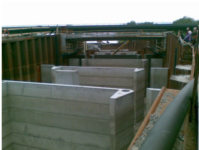
Abb. 1: Herstellung eines Schlitzpasses für den neuen Fischaufstieg am Wehr Geesthacht, nördliches Elbufer (TÖPPE 2010)
