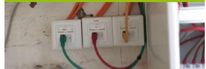
Netzwerk und MODBUS für die Steuerung der Sonnenbatterie und die Zähler
