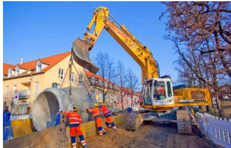
Kanalbauarbeiten in der Ingolstädter Straße in Neumarkt i. d. Opf. Foto: Firmengruppe Max Bögl_Reinhard Mederer
