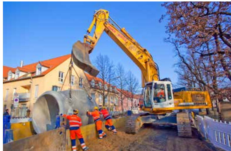
Kanalbauarbeiten in der Ingolstädter Straße in Neumarkt i. d. Opf. Foto: Firmengruppe Max Bögl_Reinhard Mederer
