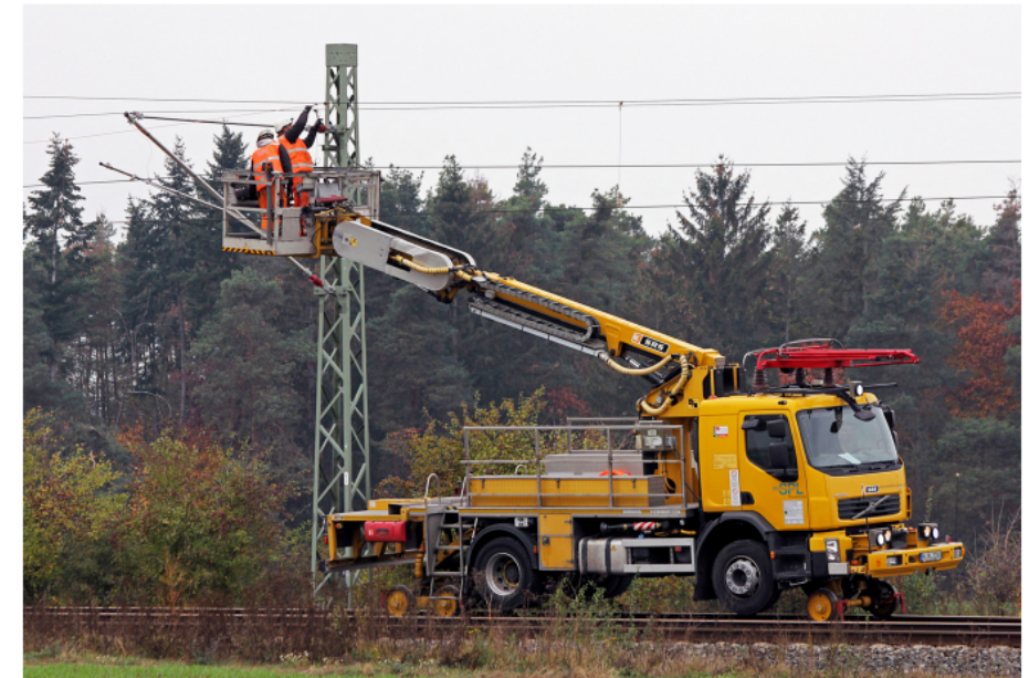
Für eine bessere Anbindung zum Ruhrgebiet wird der Streckenabschnitt Wesel – Bocholt elektrifiziert und mit Elektronischer Stellwerkstechnik (ESTW-Technik) ausgerüstet [Quelle: Symbolbild, Deutsche Bahn AG/Claus Weber]
