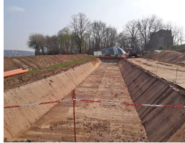
Die Teststrecke für Erdkabel ist 50 Meter lang.
