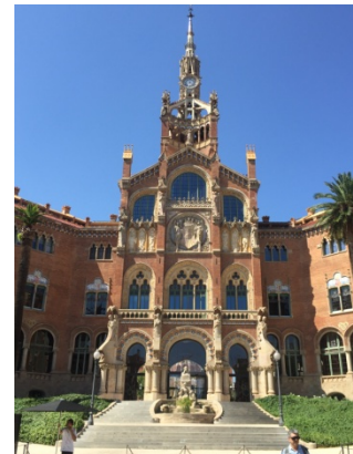
Die Fassade des Hospital de Sant Pau
